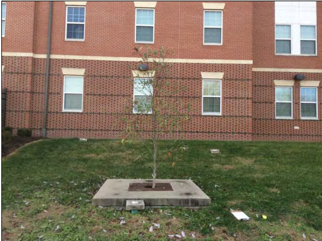
BMP 1-6, 16-21: Roof Inlet Filterra (Typ.)
